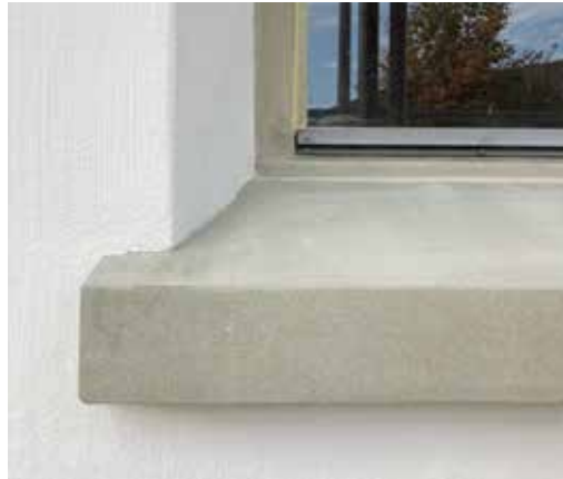
Neues Fensterbankdetail nach der Sanierung im Jahr 2020 (ds, 9.10.2020 )
