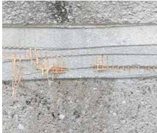
Alter Turmverputz mit zwei Lagen Armierungsnetz während der maschin. Abschleifarbeiten (ds, 10.6.2020)
