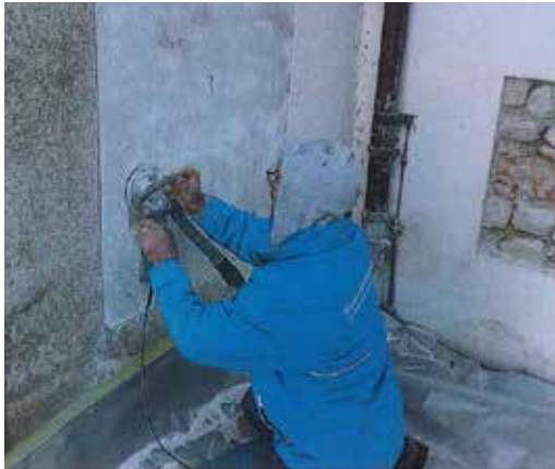
Sondierung des Verputzaufbaues am Kirchturm und am Kirchenschiff (Putz - Untersuchungsprotokoll, Firma Meier-Ehrensperger 19.12.2013)
