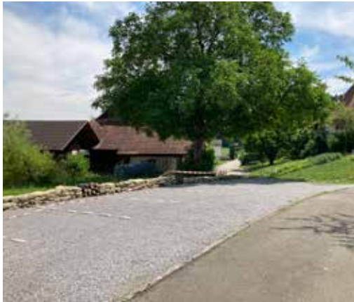
Neuer Parkplatz mit Kiesbelag und Einfassung mit einer Natursteinmauer (ds, 28.6.2021)
