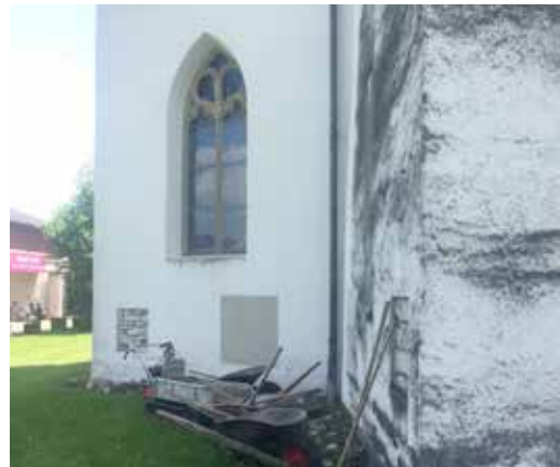
Verputzt und Anstrich an Kirchturm und Chorfassade vor der Sanierung (ds, 19.5.2020)
