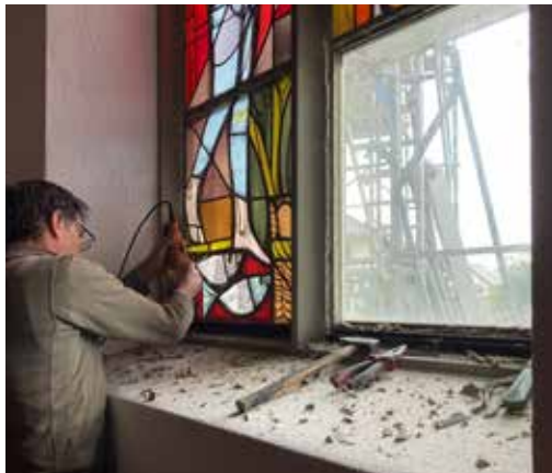
Ausbau der Kunstverglasungen zu Beginn der Sanierungsarbeiten (ds, 5.6.2020)
