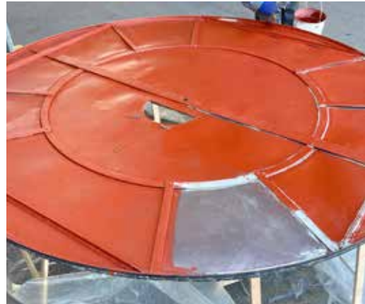
Revision der bestehenden Zifferblätter: Aufbringen der neuen Grundierung (ds, 30.6.2020)
