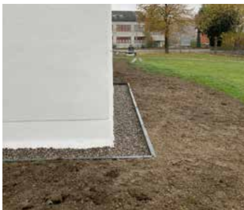
Sockel am Kirchturm nach der Sanierung mit Kiesstreifen und einer Natursteinstellplatte zum Rasen (ds, 3.11.2020)
