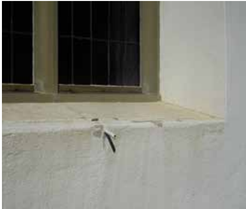
Altes Fensterbankdetail aus der Sanierung im Jahr 1968 (ds, 16.3.2020)
