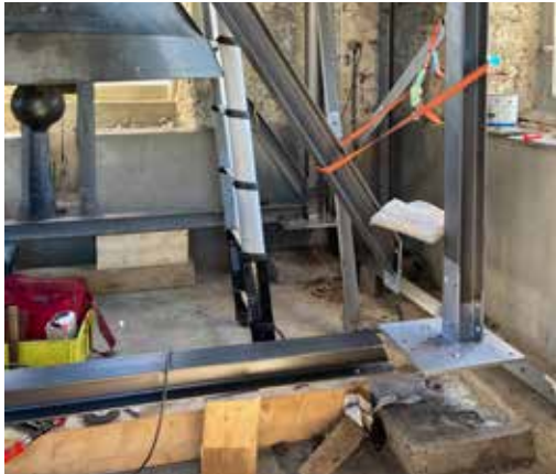
Sanierungsarbeiten am temporär angehobenen Glockenstuhl: Rostschäden beheben, neue Schwingungslager (ds, 3.9.2020 )
