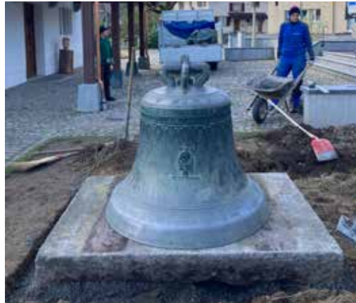
Die an neuer Lage gesetzte historische Kirchenglocke (ds, 14.4.2021)
